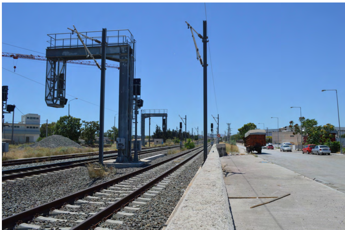
Εικόνα Β. 8.1.1. Οι σιδηροδρομικές γραμμές στην περιοχή του Ελαιώνα. Πηγή: Προσωπικό αρχείο
