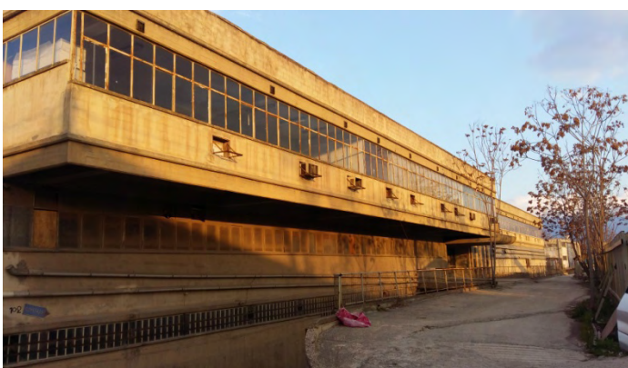
Εικόνα Β. 7.2.3. Εγκαταλελειμμένο εργοστάσιο 2. Πηγή: Προσωπικό αρχείο.
