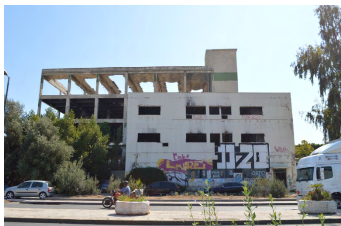
Εικόνα Β.7.2.4. Εγκαταλελειμμένο εργοστάσιο. Πηγή: Προσωπικό αρχείο
