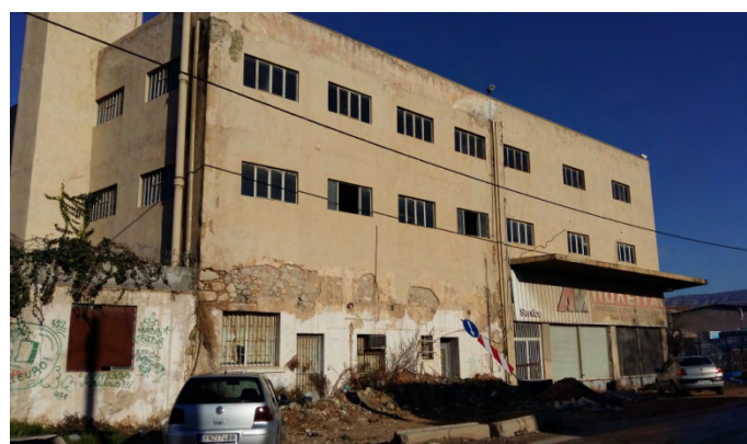
Εικόνα Β.7.2.2. Εγκαταλελειμμένο εργοστάσιο 3. Πηγή: Προσωπικό αρχείο.
